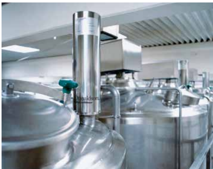
Obudowy filtrów oddechowych zamontowane na zbiornikach.
