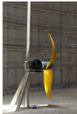
System prowadnic sprawia, że mieszadła są łatwo dostępne.
